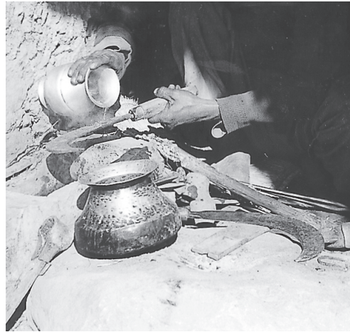
図 1.9-2 鎌は熱した刃先部分に水をかけて焼きを入れる
