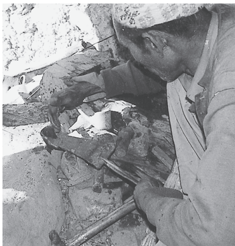
図 1.9-6 鋤のひつと鋤先を噛み合わせ、合わせた部分に水で溶いた硼砂(鍛接剤)をぬって加熱し鍛接する
