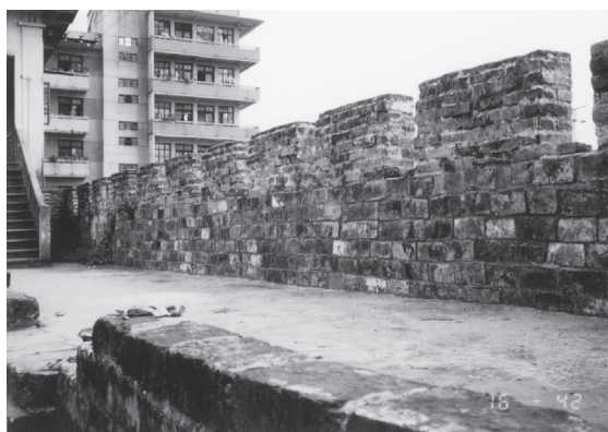
写真1 現存する永安州の城壁
